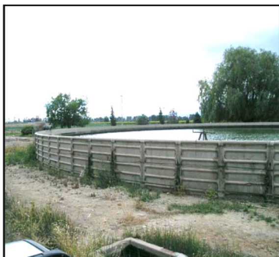
FIGURA A.4 - Tanque
