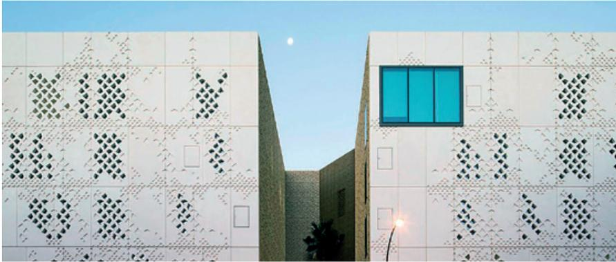
La Norma UNE-EN 14992 *Productos prefabricados de hormigón. Elementos para muros* indica en su alcance que “es de aplicación a muros prefabricados de hormigón. También se puede emplear hormigón armado con fibras (de acero, polímero u otras fibras cubiertas por las normas europeas). Estos elementos para muros pueden tener aplicación exterior o no, aplicación de fachada o no y/o una combinación de estas aplicaciones”.
