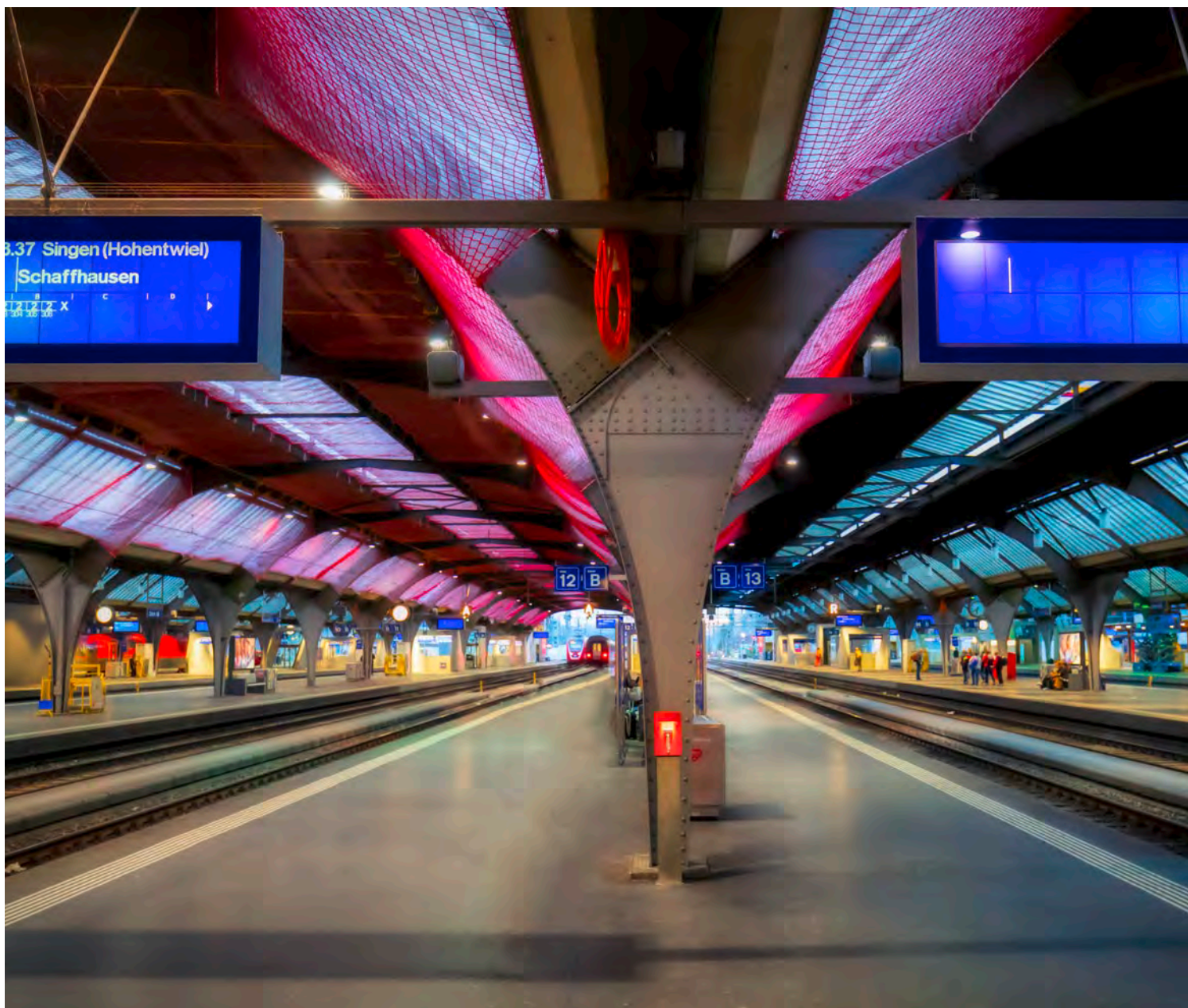
Infraestructura ferroviaria de última generación en la estación principal de Zúrich, Suiza.
