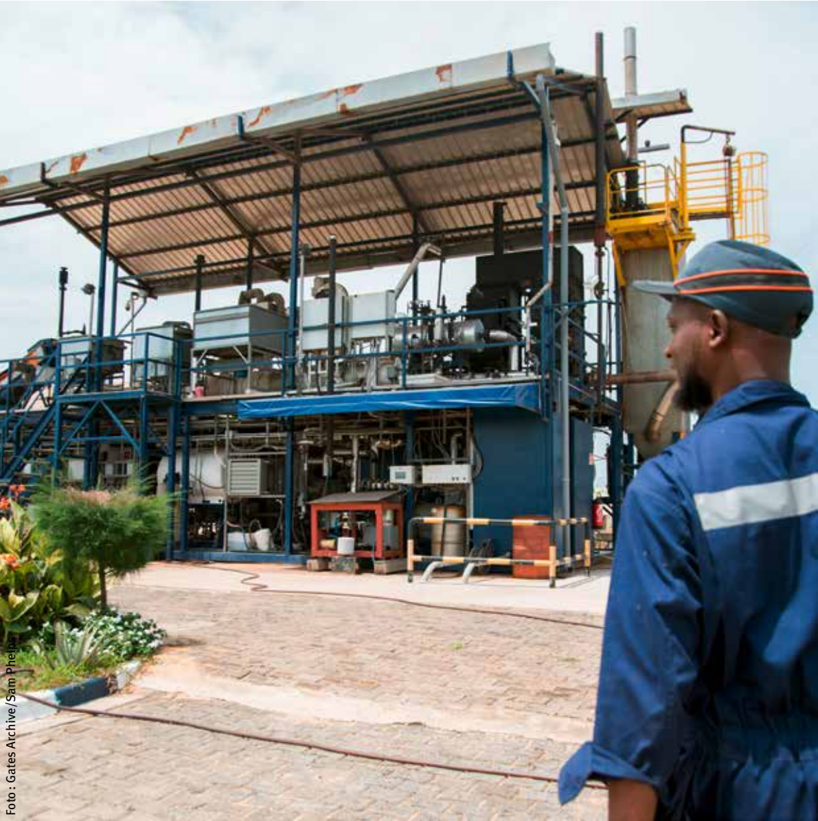
El Omni Processor de Janicki se instaló en Dakar, Senegal, en 2015 y ahora se encarga del tratamiento de residuos fecales de cientos de miles de personas.
