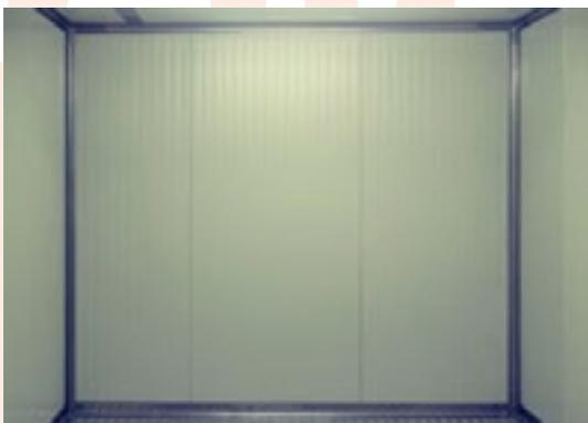
**Figura 5:** Paredes y techos de color claro, de acabado liso, impermeable y fácil de limpiar
