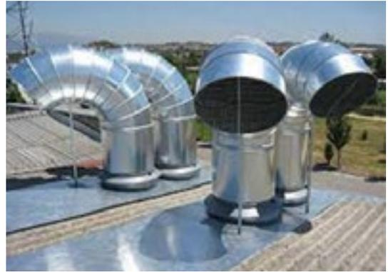
**Figura 18:** Toma de aire de un sistema de ventilación en techos
