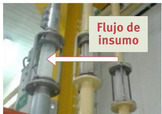
**Figura 19:** Transporte neumático de insumos a granel
