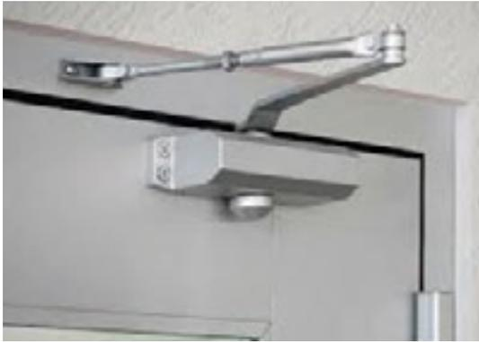
**Figura 23:** Brazo hidráulico para mantener la puerta cerrada
