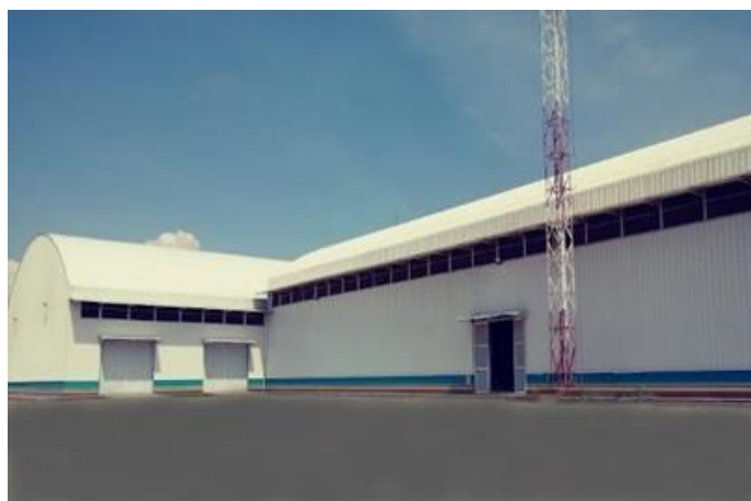
Figura 2 - Accesos a una fábrica pavimentados
