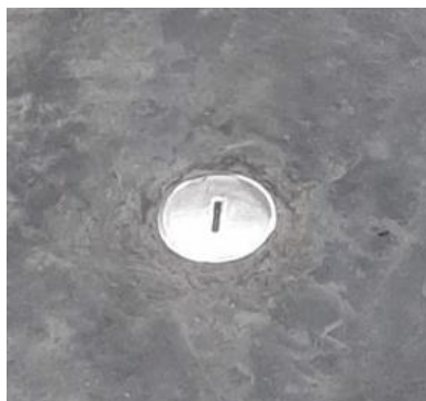
Figura 38 - Registro de desagüe
