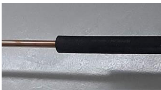
Figura 9 - Tubería con aislamiento de espuma elastomérica para evitar la condensación o goteo
