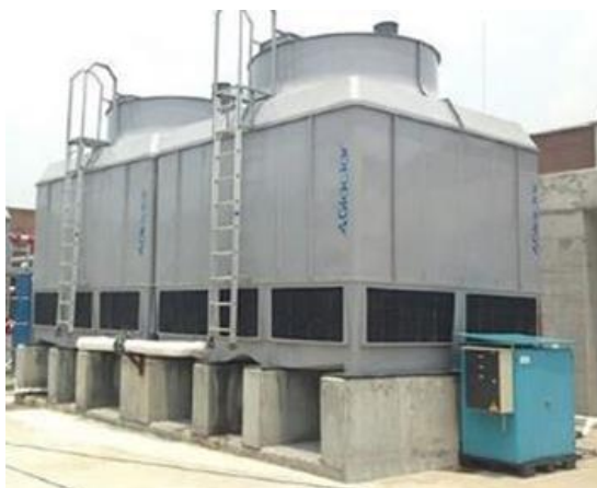
Figura 34 - Torres de enfriamiento ubicados en áreas externas
