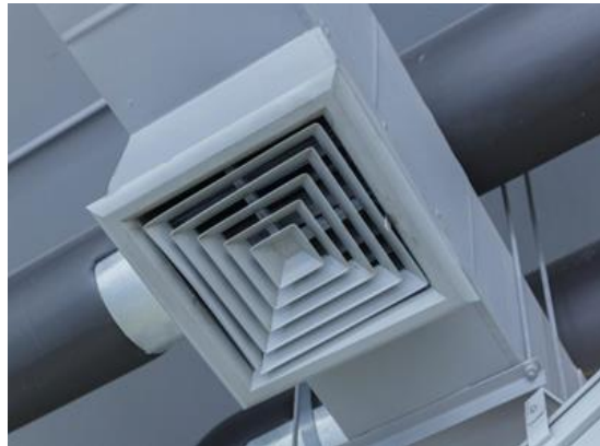
Figura 17 - Rejillas de un sistema de ventilación
