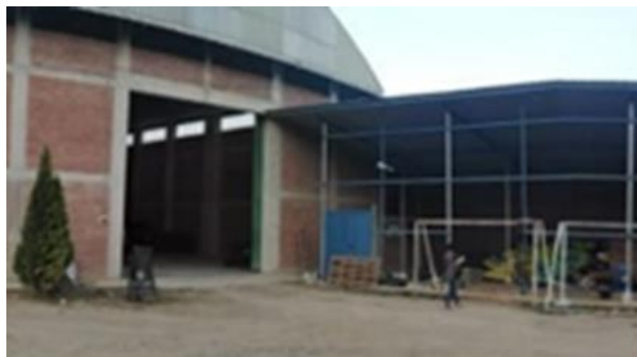
Figura 3 - Perímetro de un establecimiento con objetos y maquinaria en desuso
