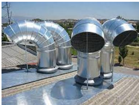
Figura 18 - Toma de aire de un sistema de ventilación en techos
