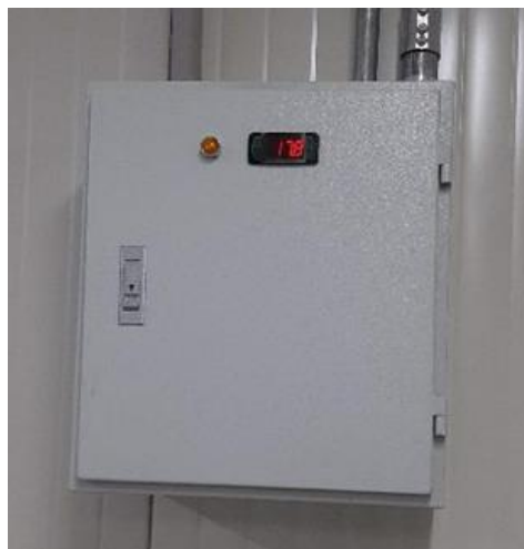
Figura 33 - Dispositivo de control de temperatura en ambiente
